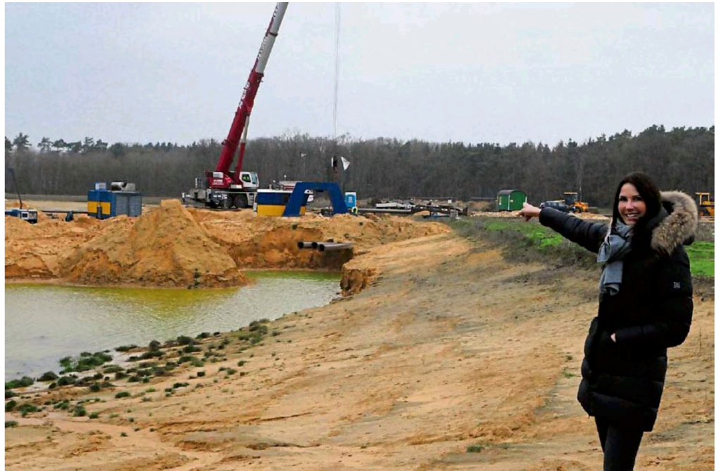
Die Ausbaggerung des Sees im Gebiet Busemühle ist im Gange. Britta Dröge ist zufrieden mit dem Fortgang der Bauarbeiten und der Nachfrage nach den Grundstücken im Wohnpark.
