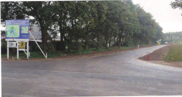
Die neue Zufahrt von der Haselünner Straße zum Baugebiet "Am See Busemühle" - Links daneben die alte Eichenallee, die später als Rad-/Fußweg dienen wird
