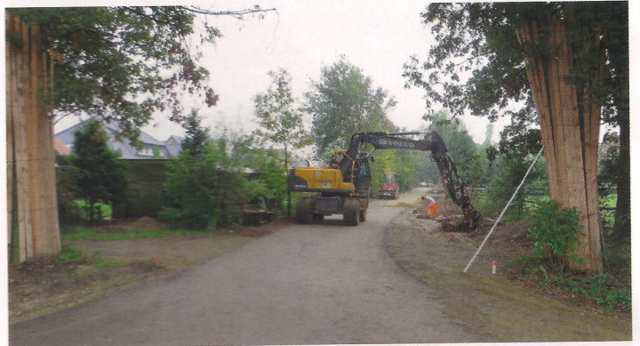
Die Zufahrt zum Baugebiet hinter dem Wohngebiet an der Haselünner Straße
