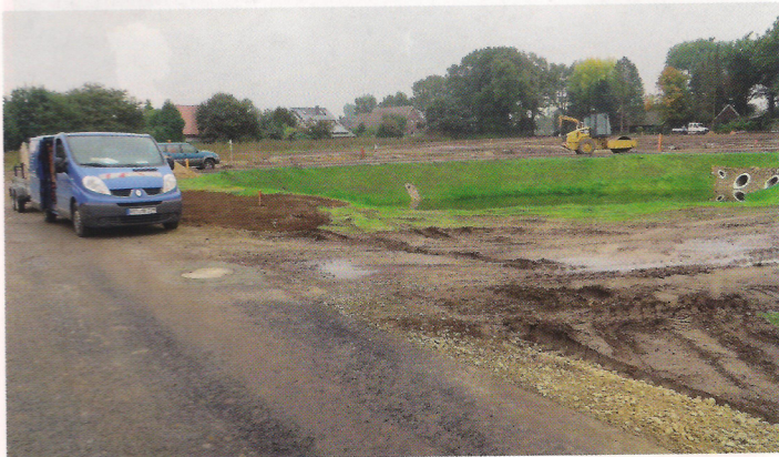
Der östliche Teil des 1. Bauabschnitts: Im Vordergrund das Regenrückhaltebecken, hinter dem Haus rechts verläuft die Hase
